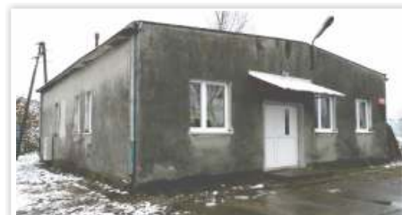
Budynek przed remontem
