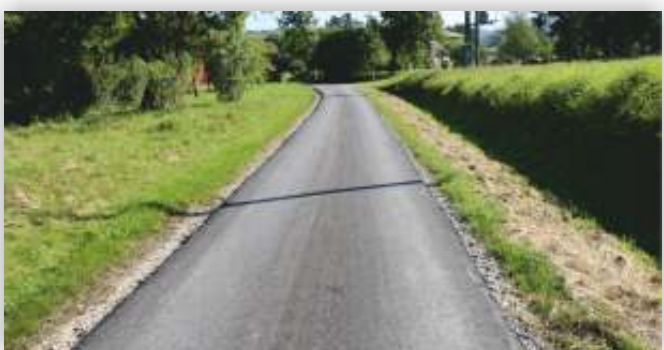
Wyremontowany odcinek w Kobyłanach
