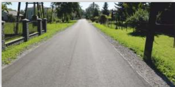
Wyremontowany odcinek w Zręcinie
