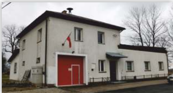
Remiza OSP przed remontem
