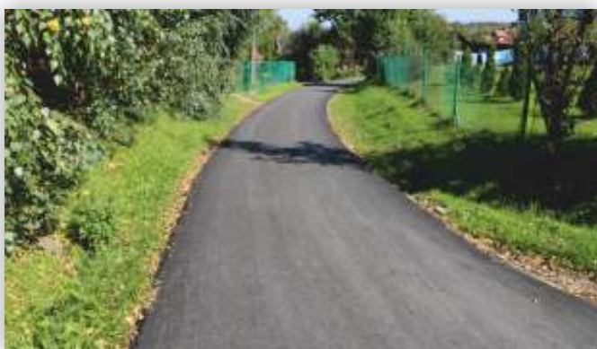
Wyremontowany odcinek w Faliszówce
