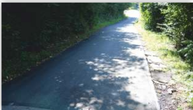
Wyremontowany odcinek w Poraju
