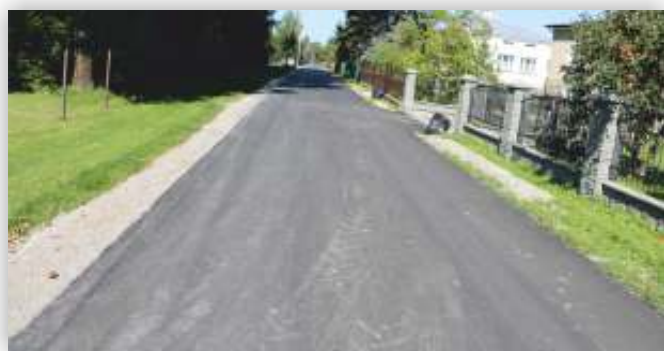
Wyremontowany odcinek w Zręcinie
