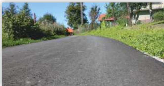
Wyremontowany odcinek w Kobyłanach
