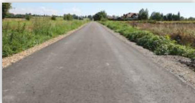
Wyremontowany odcinek w Chorkówce
