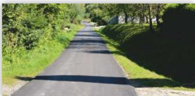
Wyremontowany odcinek w Żęglcach
