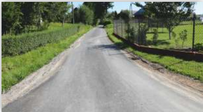
Wyremontowany odcinek w Bóbrce
