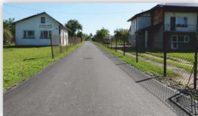
Wyremontowany odcinek w Świerzowej Polskiej
