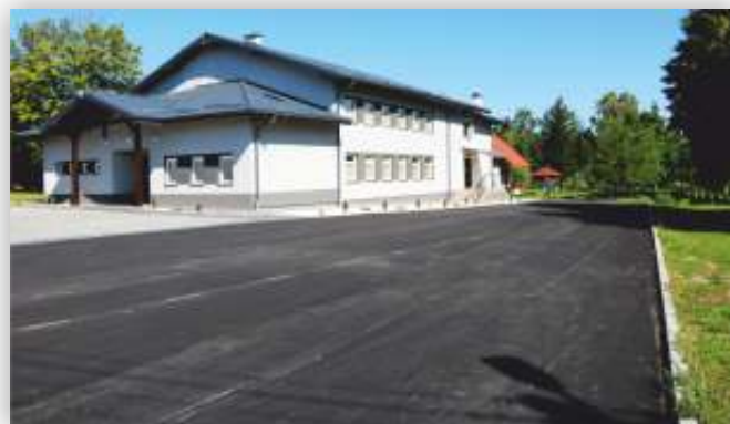
Parking przy Domu Ludowym
