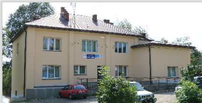
Budynek wielofunkcyjny w Chorkówce
