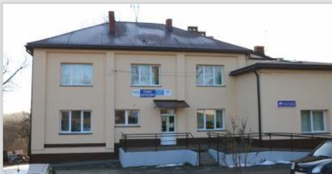
Budynek wielofunkcyjny w Chorkówce po remoncie
