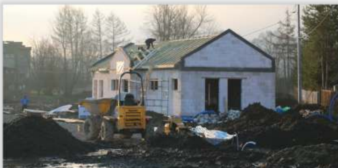
Budynek dla sportowców na terenie boiska wielofunkcyjnego
