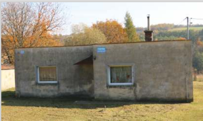
Budynek hydroforni w Kobylanach - przed remontem
